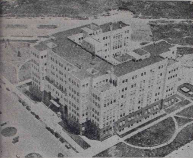
Vista aérea del magnífico edificio de la Administración de los Ferrocarriles General Belgrano, ex-Ferrocarriles del Estado
