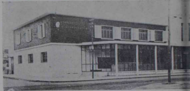
Para la ciudad correntina de Cuzú Cuatía, ha sido elegido como sede de las oficinas de Correos y Telecomunicaciones, este tipo de edificio, moderno, con amplias ventanales y puertas vidrieras, que permiten el máximo y más adecuado aprovechamiento de la luz natural y del aire For Curuzu Cuatía (Corrientes) this is the type of building that has been selected for the Post Office. Large window and glass doors ensure plenty of light and ventilation
