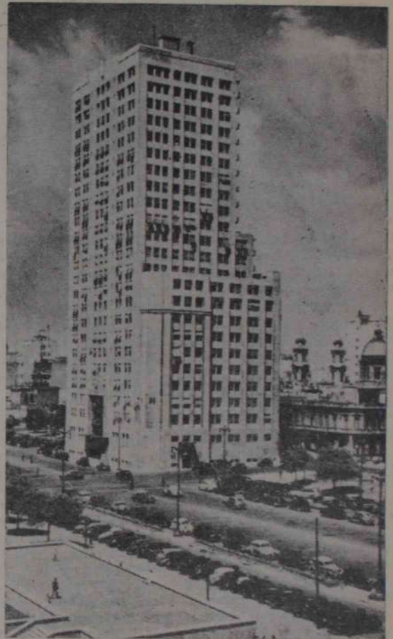
Aspecto del monumental edificio del Ministerio de Obras Públicas, situado en la Avenida 9 de Julio entre las calles Belgrano y Moreno
