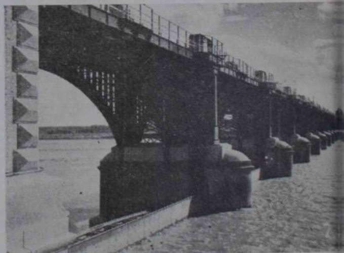
Vista del dique nivelador del Neuquén, sólido y hermoso exponente del alto grado de adelanto y perfeccionamiento a que ha llegado la ingeniería argentina. Tiene este dique una extensión de cuatrocientos metros, y en la actualidad beneficia con su riego a 52,000 hectáreas. Esta gigantesca obra ha costado la cantidad de $ 18,000,000
