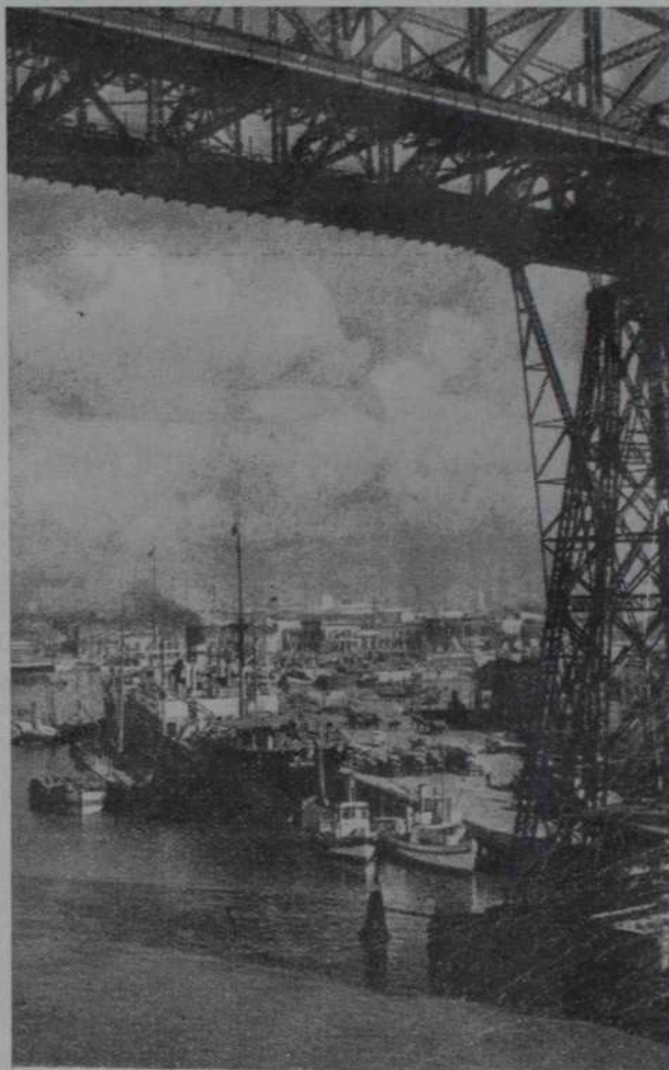
El Riachuelo, que separa Buenos Aires de la ciudad industrial de Avellaneda con su tráfico marítimo y fluvial, ofrece uno de los lugares más pintorescos e industriales de la Capital
