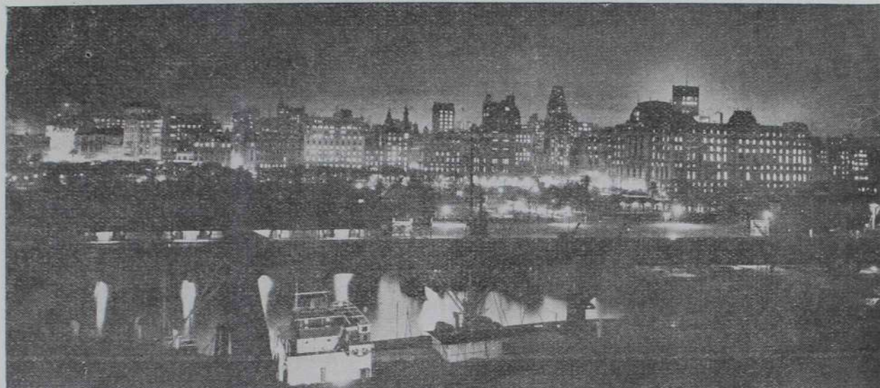
Night view of Buenos Aires, seen from the waterfront) Hermosa vista nocturna de Buenos Aires, contemplada desde la zona portuaria
