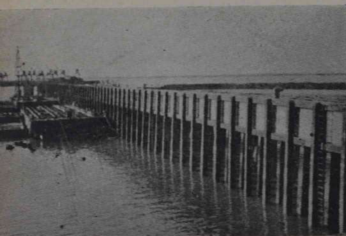
A nueve millones de pesos llegó el presupuesto del Puerto Nacional de Bahía Blanca. En la presente fotografía observamos el muelle de hormigón armado, en dársena de cabotaje
