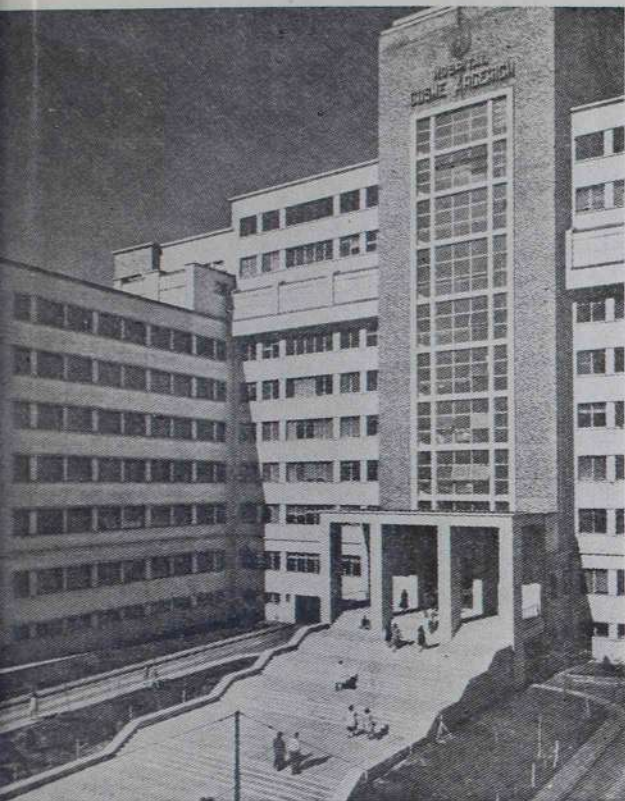
Vista del espléndido hospital municipal Cosme Argerich, con una capacidad de más de 700 camas, constituyendo uno de los más modernos nosocomios puesto al servicio de la población metropolitana. Buenos Aires cuenta con un de los mejores servicios hospitalarios del mundo
