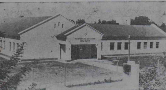
Escuela primaria de Humbolt, Santa Fe. De conformidad con las previsiones del Plan Quinquenal, el Ministerio de Obras Públicas de la Nación encaró la realización de un amplio programa de construcciones de edificios destinados a escuelas nacionales primarias. Dicho programa de construcciones comprendió un total de más de 1.000 escuelas en todo el país, las cuales fueron entregadas al ministro de Educación con todas las instalaciones, servicios y mobiliario necesarios
